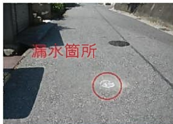
掘削することなく漏水箇所を特定
